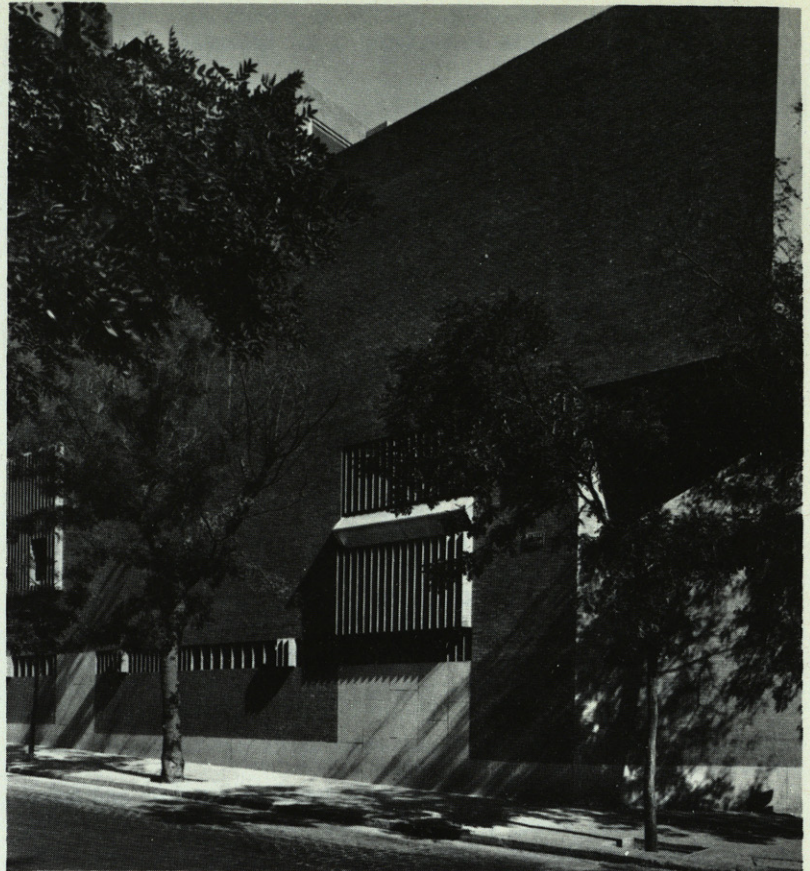
EMBAJADA DE SUECIA EN MADRID. Edificio que cumple también las normas internacionales de seguridad, establecidas después de la Mundial II. Sorpresa gratísima en la calle de Caracas.
