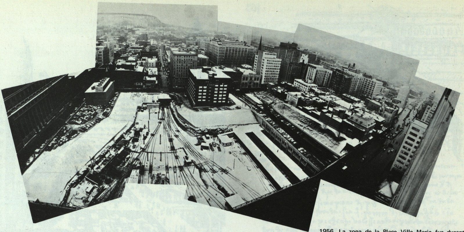
1956. La zona de la Place Ville Marie fue durante años un inmenso agujero en el centro de la ciudad. En la foto se muestran los railes de la Canadian National (15 metros por debajo del nivel de la calle) convergiendo en la boca del túnel. El túnel se construyó en 1912 pasando por debajo de la ciudad y de las montañas al norte (en la foto al fondo) y vuelve a salir al otro lado del Mount Royal. La foto está tomada desde los últimos pisos del hotel Queen Elizabeth, entonces en construcción.
