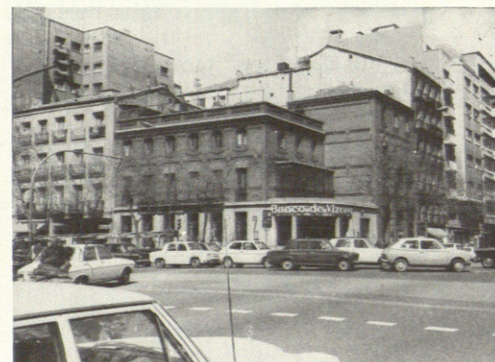
Situación: C/ Velázquez, 97, esquina de Diego de León Fecha de construcción: 1892 Arquitecto: Manuel Martínez Angel
