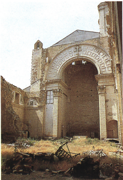
Estado actual del interior de la iglesia.
